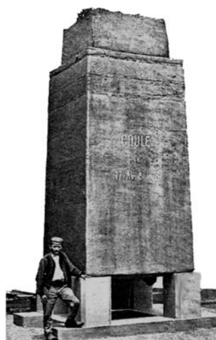
Lingot de 120 t Coulé au Creusot le 17 avril 1878 (mise en œuvre de 7 fours Martin)
